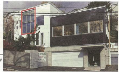
実験棟の外観。赤線で囲んだ部分が太陽熱集熱板(Jコネクター)
