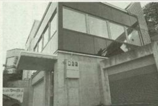
壁にも太陽光パネルを搭載
