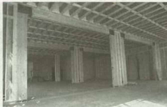
J耐震開口フレームの施工現場
