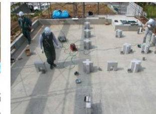
グリッドポスト施工状況
