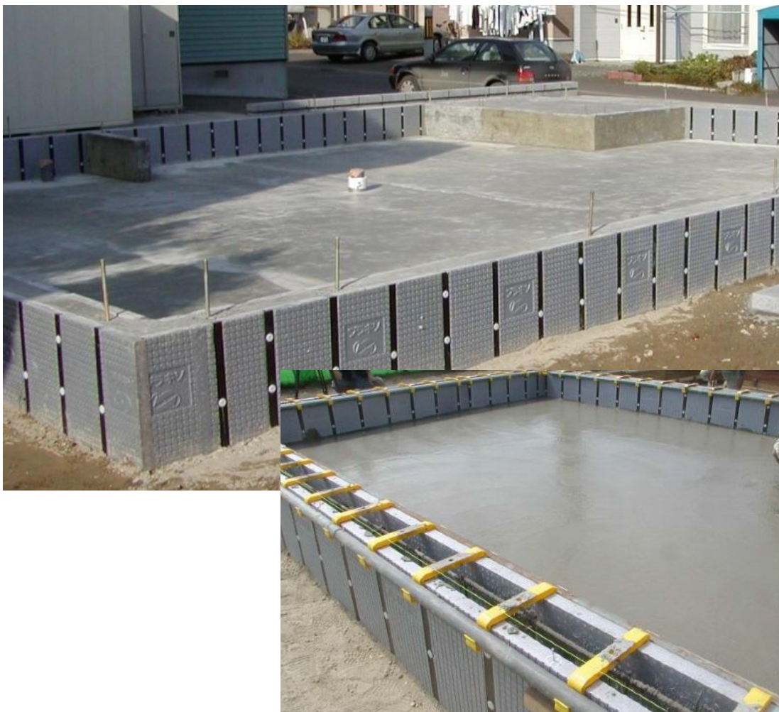
断熱材兼用一体打ち型枠
