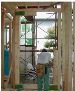
BOX型フレーム設置状況
