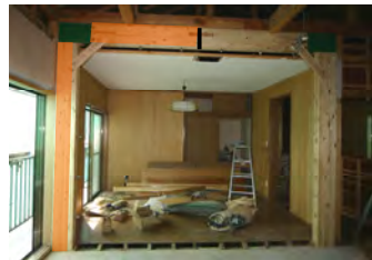
門型〔中間接合〕 （内部間仕切り壁の撤去後の補強）
