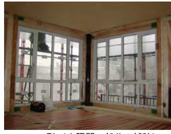
BOX型（出隅開口部分の補強）
