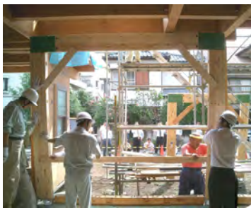
門型フレーム設置状況
