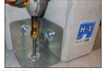
回転打撃によりアンカーの打込み
