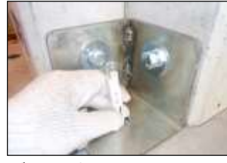
グラウト式CCアンカーの埋込み
